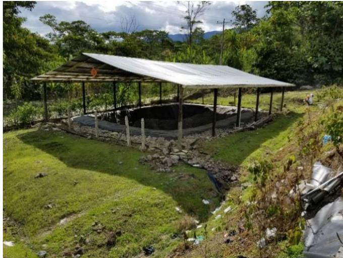
*Fotografía 14. Celda para residuos especiales y sanitarios.*
